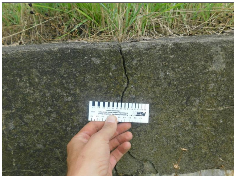
Svislá trhlina v pravé římse šířky 2,5 mm.
