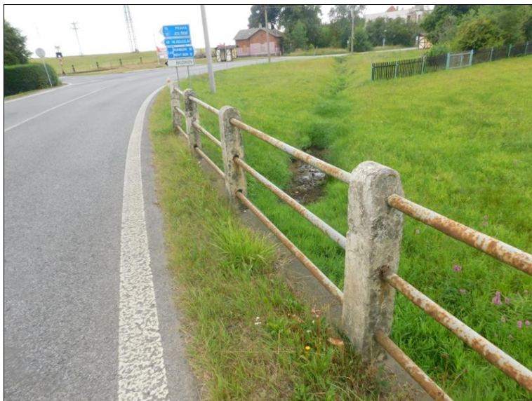
Vozovka na mostě je převrstvená, zábradlí na pravé straně silně koroduje.
