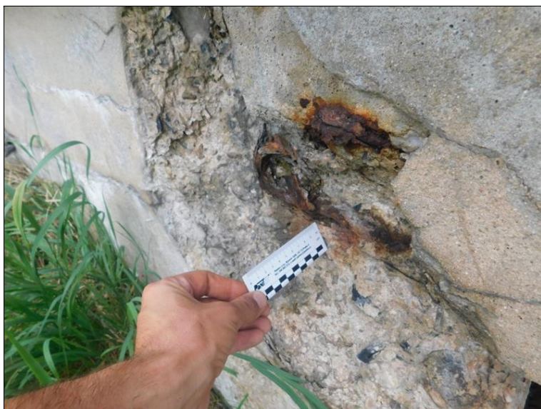
Hlubková degradace boku nosné konstrukce nad opěrou OP1 vpravo. Silná koroze výztuže.
