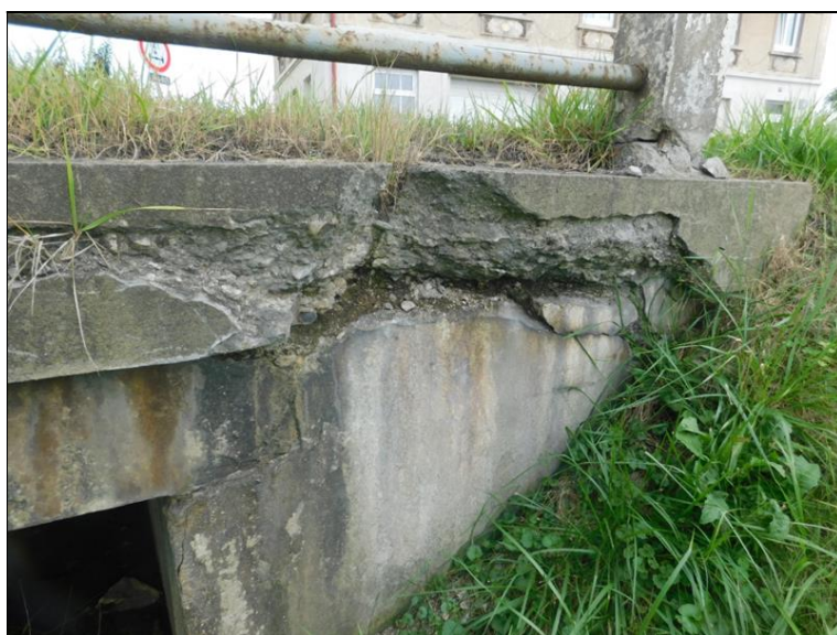
Hlubková degradace betonu pravé římse nad opěrou OP3.
