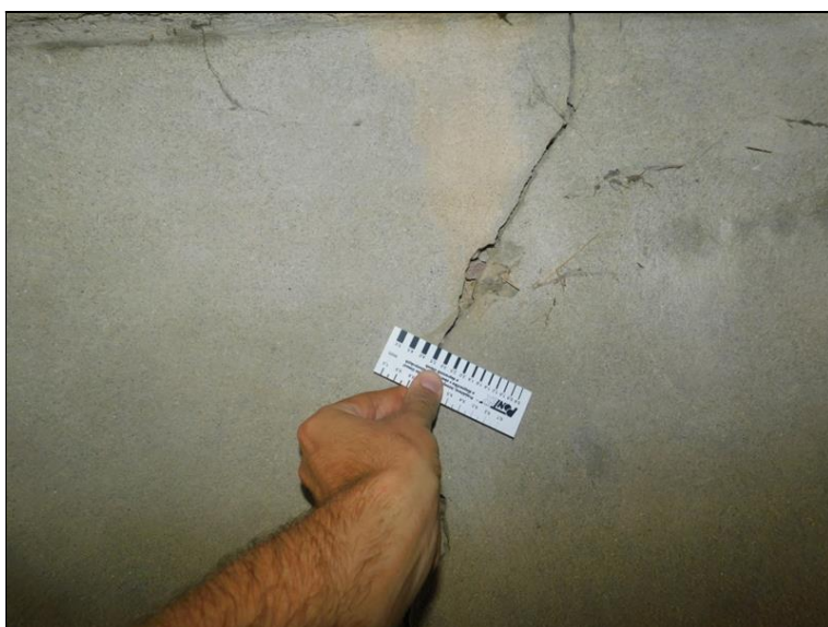
Svislá trhlina na líci opěry OP3 v poli 2.
