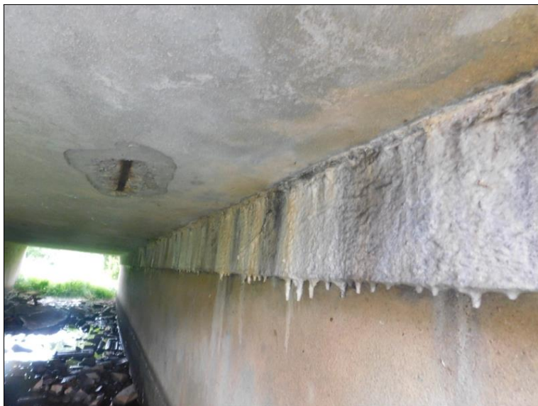
Silné průsaky s výluhy na líci pilíře P2 do pole 1.
