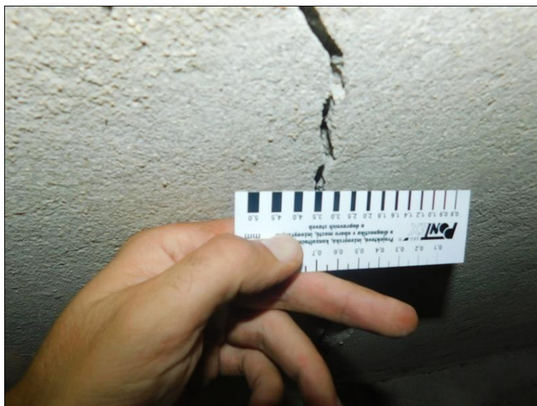
Podélná trhlina na spodním líci nosné konstrukce cca v polovině šířky nosné konstrukce. Šířka trhlina je 3,5 mm.
