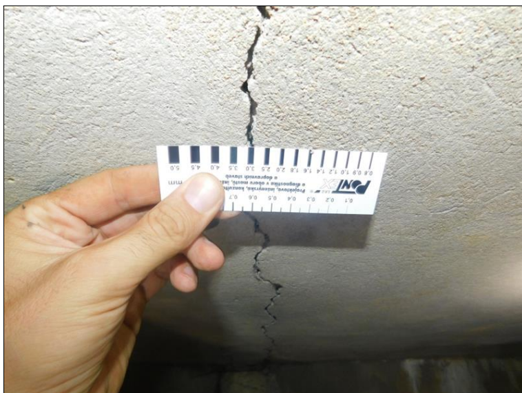
Detail podélné trhliny v mostním poli 1 cca v polovině šířky konstrukce - šířka trhliny 3,5 mm.
