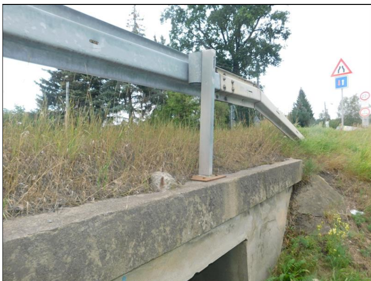
Vysoký sloupek svodidla - jeho únosnost je omezená. Vozovka převrstvená až o 20 - 30 cm.
