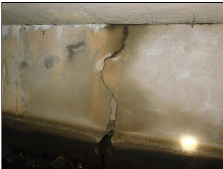
Svislá trhlina cca v polovině šířky opěry OP1.
