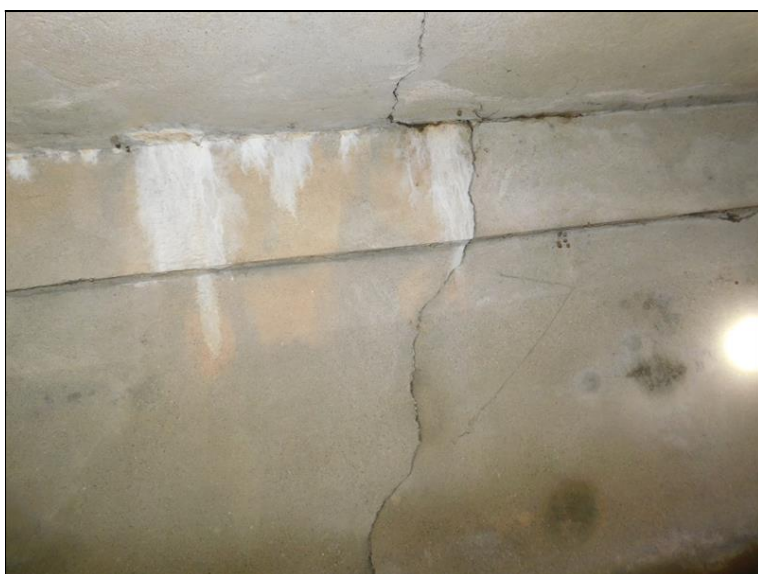
Svislá trhlina v poli 2 na lici pilíře.
