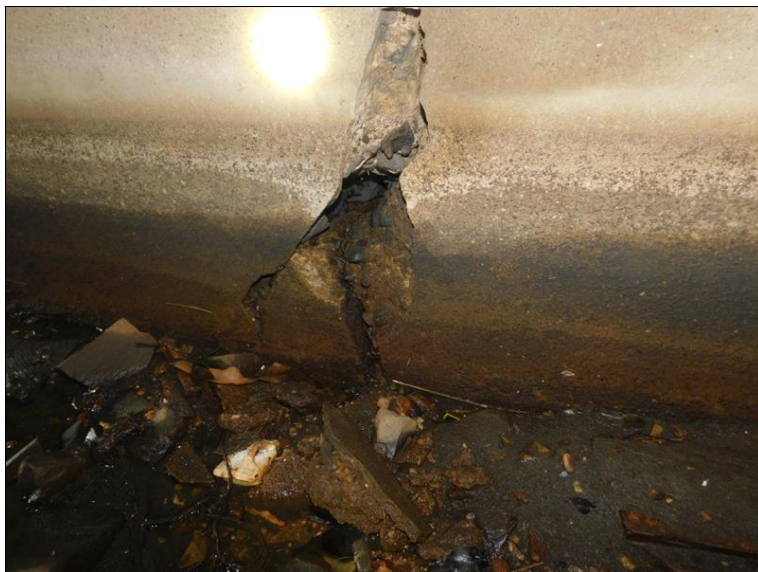
Rozpad betonu a široce otevřená spára v patě opěry OP1.
