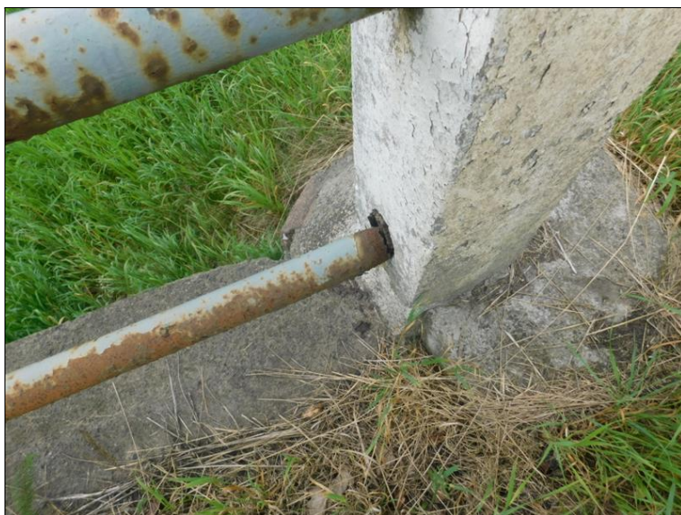
Překorodované madlo zábradlí v patě.
