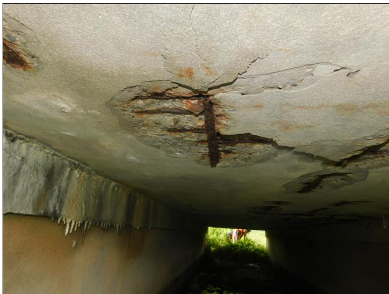
Plošně separovaná krycí vrstva betonářské výztuže - silná koroze betonářské výztuže v poli 2.
